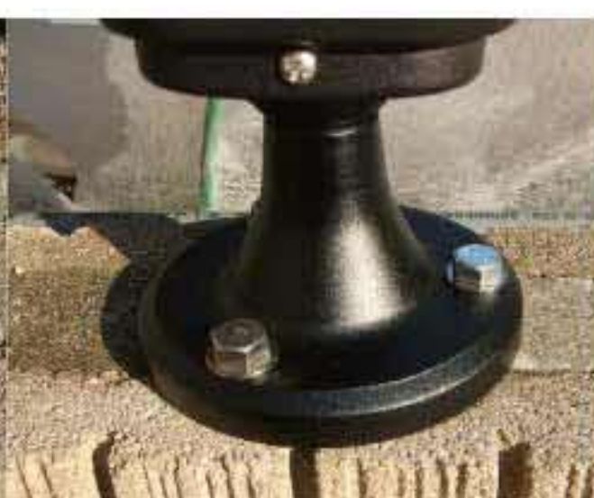
専用プレートを使って、市販の接着剤（コンクリート＋金属用）のみで設置可能
