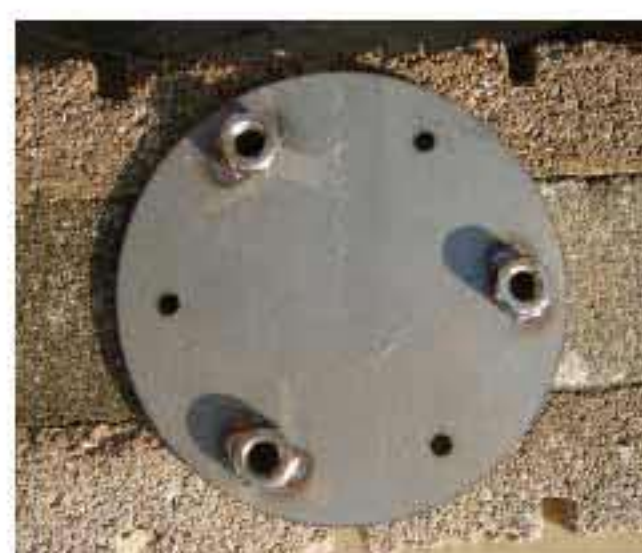
専用プレートを使って、市販の接着剤（コンクリート＋金属用）のみで設置可能
